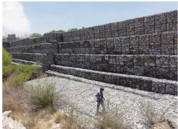
Figura 3. Detalle de la cortina de gaviones en la descarga del vertedor.
