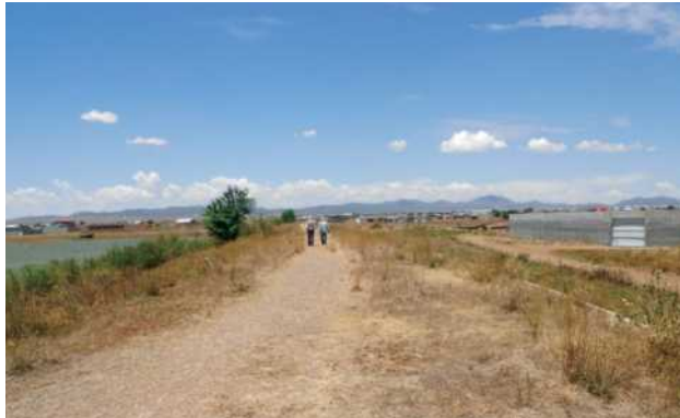
Figura 4. Corona de la presa Los Burros; en el lado izquierdo se aprecia el vaso.
