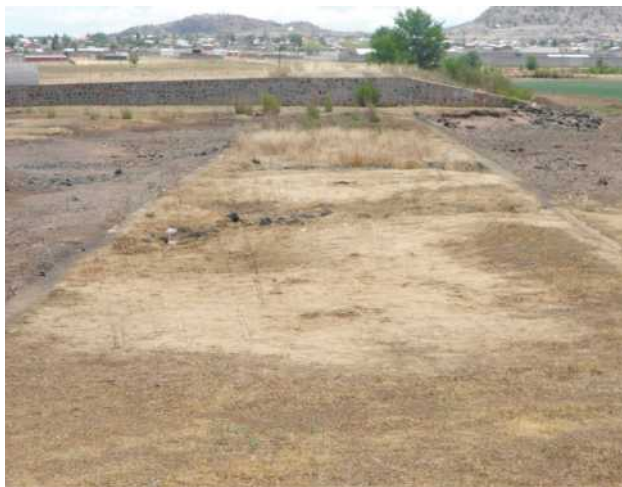
Figura 5. Sección de control del vertedor. Se observan los dos dentellones y el relleno intermedio. Al fondo, el crecimiento urbano cercano a la infraestructura.
