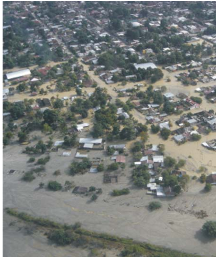
Figura 4. Vista aérea, colonia FONAPO sepultada en arena, en Huixtla, Chiapas.
