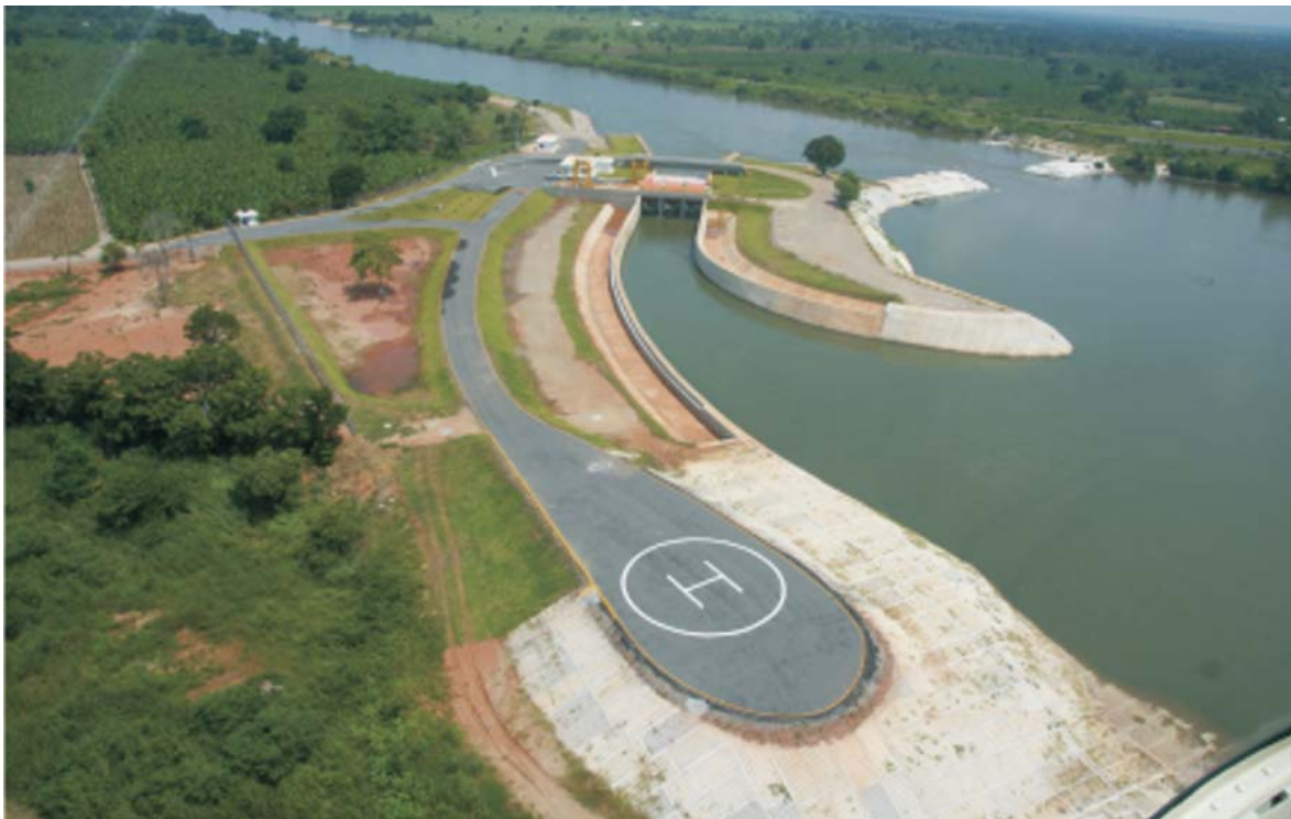
Figura 4. Margen izquierda de la estructura de control del río Carrizal.
