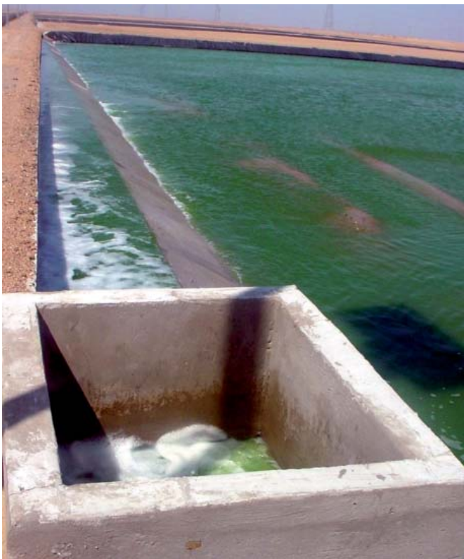
Figura 10. Inicio de infiltración.
