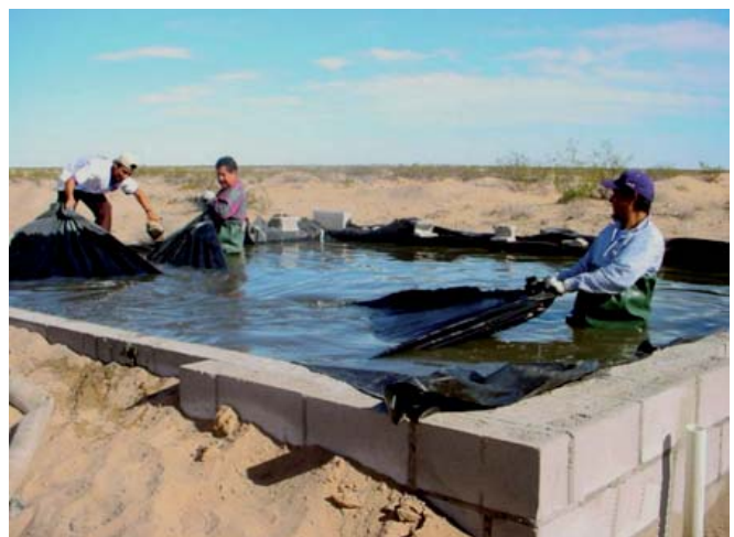
Figura 4. Llenado de pileta de infiltración con agua potable.
