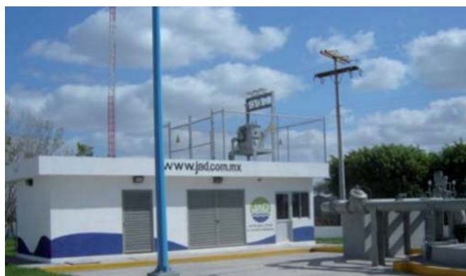
Figura 4. Estación de Bombeo No. 40.
