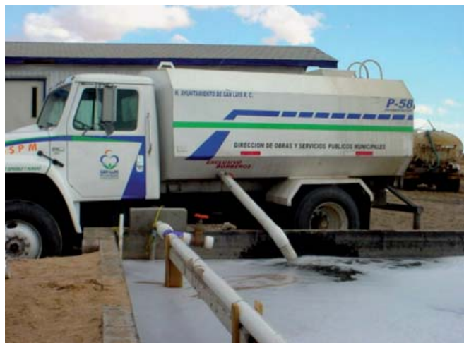
Figura 6. Llenado de pileta con agua residual tratada.
