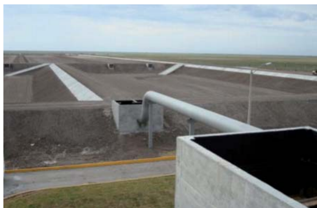
Figura 5. Planta tratadora de aguas residuales de la zona este.
