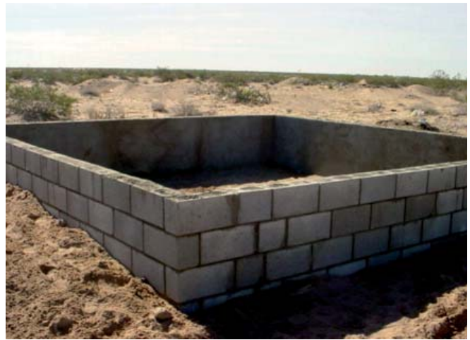
Figura 3. Pileta de pruebas de infiltración.
