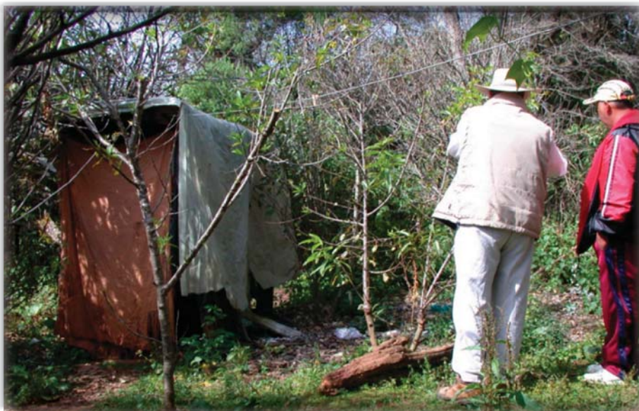
Recorrido por una vivienda para establecer la factibilidad de instalar las tecnologías.
