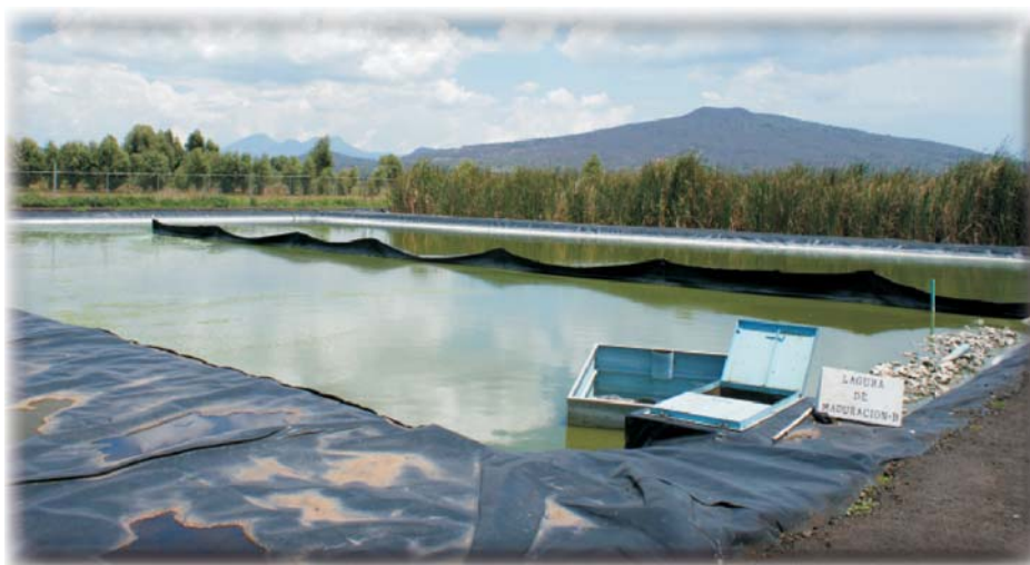
Laguna de maduración.
