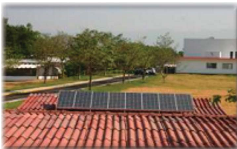
Instalación de las celdas fotovoltaicas.
