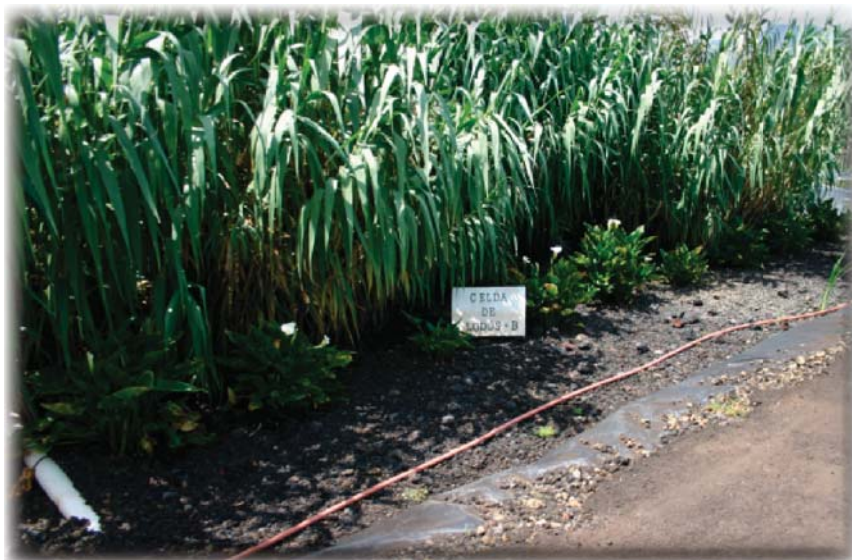
Humedal para el tratamiento de los lodos provenientes de la fosa de sedimentación.
