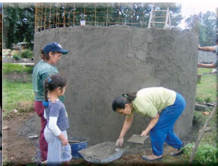
Participación de la mujer en un taller de transferencia. Instalación de una cisterna.
