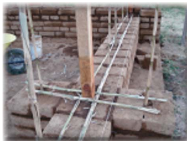
Instalación de muros de la casa ecológica.
