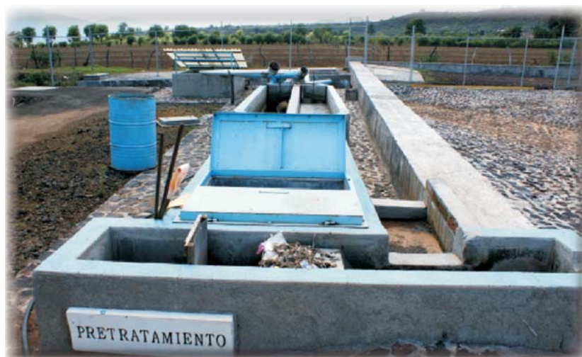
Rejilla y obra de excedencias de agua.
