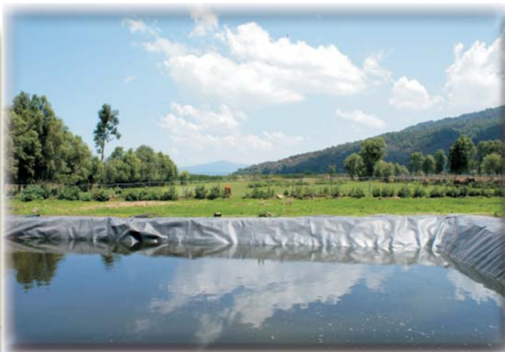
Humedal para el tratamiento de las aguas residuales de la comunidad de Cucuchucho, Tzintzuntzan, Michoacán.
