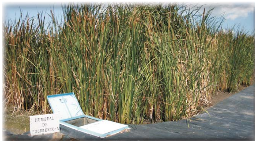
Humedal de pulimento.
