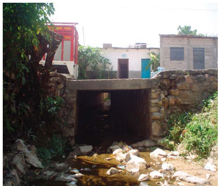
Ilustración 4 Aumento de la vulnerabilidad por invasión de cauces. (a) Sobre el lecho mayor; (b) sobre el lecho menor o cauce principal.
