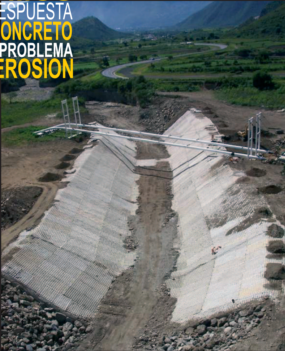
Protección de las bases del cruce aéreo "Barranca" en Cd. Mendoza, Veracruz
