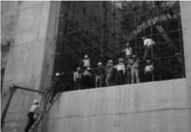
Presa hidroeléctrica "Zimapán"
