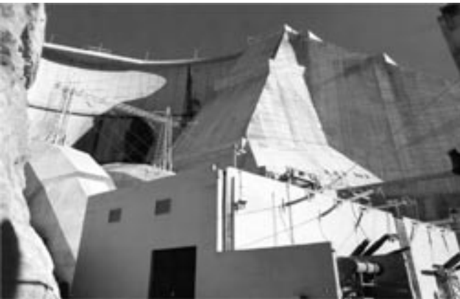
Presa hidroeléctrica "Huites" (1996)
