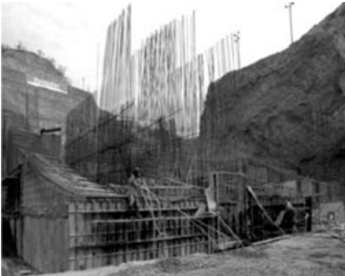
Cimentación en la presa hidroeléctrica "Cimacio"
