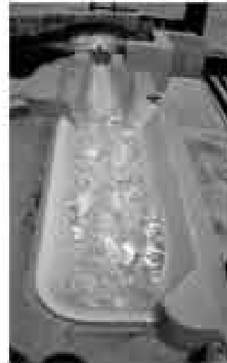
Foto 2. Vista hacia aguas arriba del vertedor y canal de descarga convencional operando con el gasto máximo.
