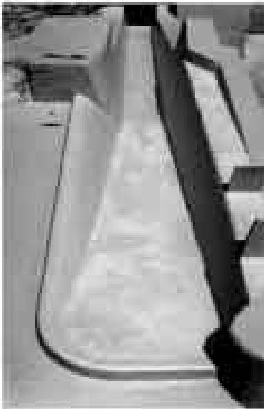
Foto 4. Vista completa hacia aguas abajo del vertedor y canal de descarga. Se observa el inicio del fondo del colector coincidiendo con la cresta del vertedor.
