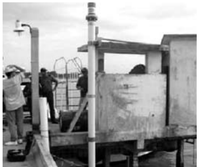
Foto 2. Vista general de la Estación mareográfica Tampico, Tamaulipas.
