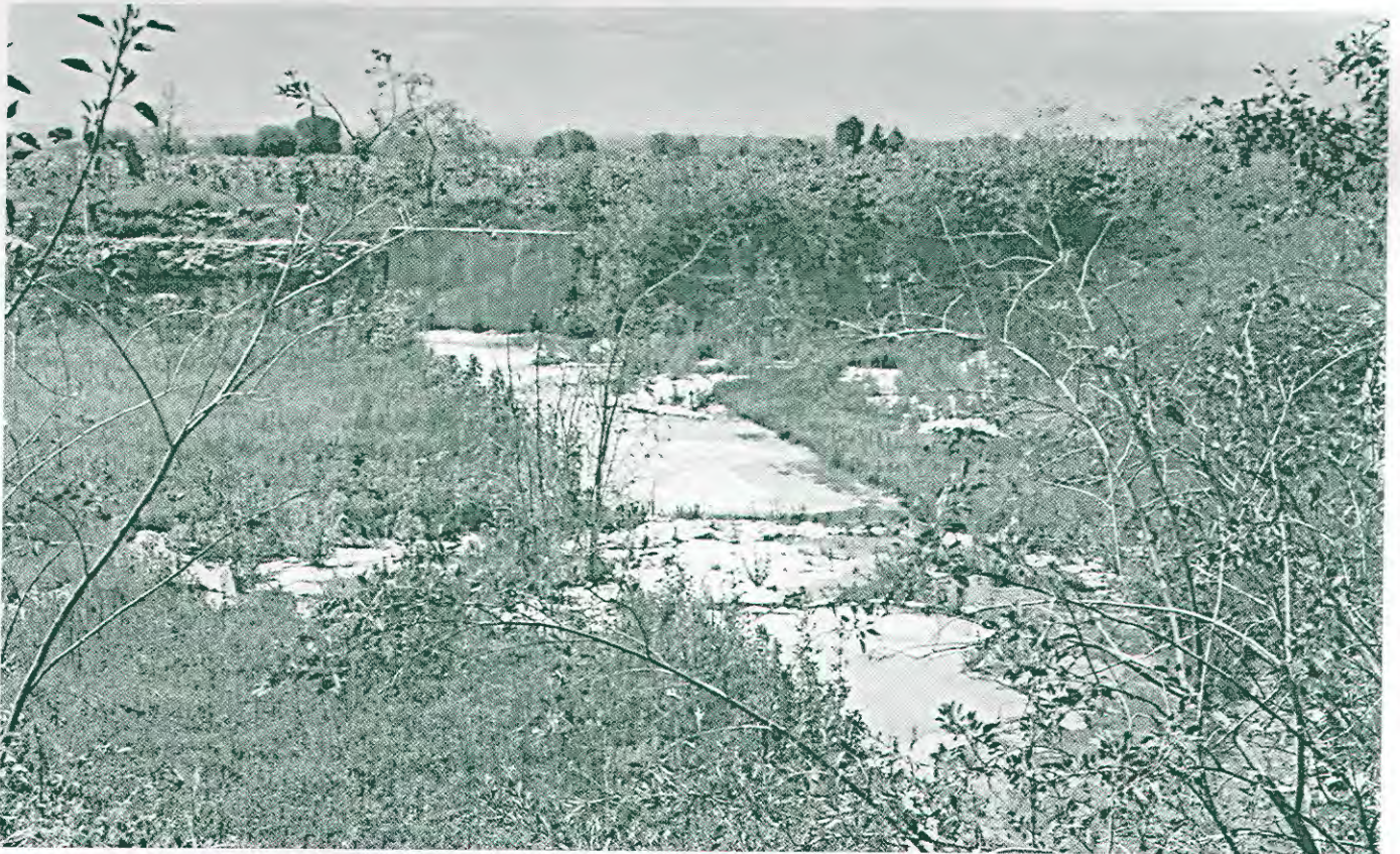
Figura 1. Losa de concreto construida sobre una falla geológica en el fondo de una laguna de estabilización.
