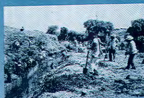
Limpieza del canal y del túnel
