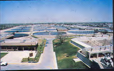
Planta Norte en Monterrey de 2,500 lps
