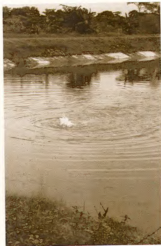
▲ LAGUNA FACULTATIVA PRIMARIA AZOLVADA
