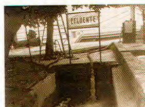
▲ EFLUENTE TRATADO DE LA PLANTA DE AGUAS RESIDUALES DE AGUAS BLANCAS, ACAPULCO (II-UNAM)
