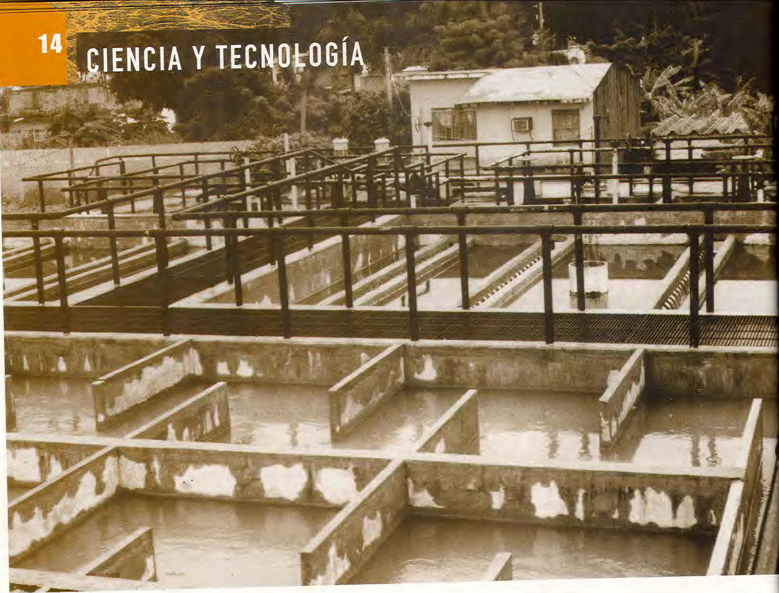
▲ FLOCULADORES, SEDIMENTADORES Y AL FONDO LOS FILTROS
