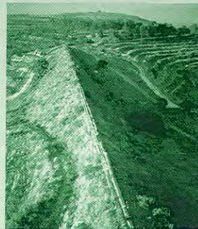
▲ TERRAPLÉN DEL SISTEMA DE REGADÍO SUR (CAÑO QUEBRADO). FOTO MICHAEL CALDERWOOD
