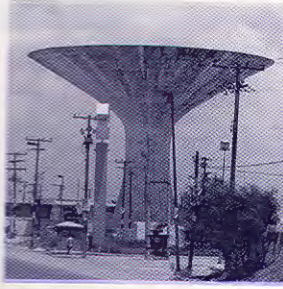
▲ TANQUE DE ALMACENAMIENTO DE AGUA REYNOSA, TAMPS.
