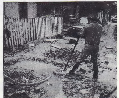
Reparación de fugas en líneas principales
