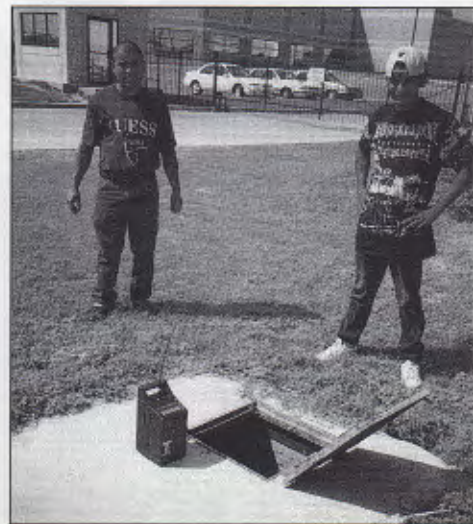
Trabajos de localización de fugas
