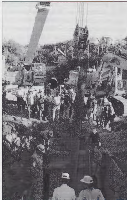
Se realizaron diversos trabajos para restablecer los servicios de agua potable y alcantarillado. Las zonas marginadas Renacimiento y Zapata fueron las primeras en tener agua.
