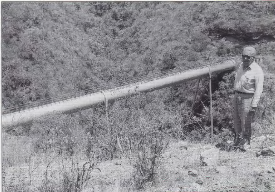
El ingeniero Torres Herrera se graduó de ingeniero civil con una tesis sobre el diseño de la estructura del puente-canal de San Miguel del sistema Cutzamala. En su época el segundo más grande del mundo.
